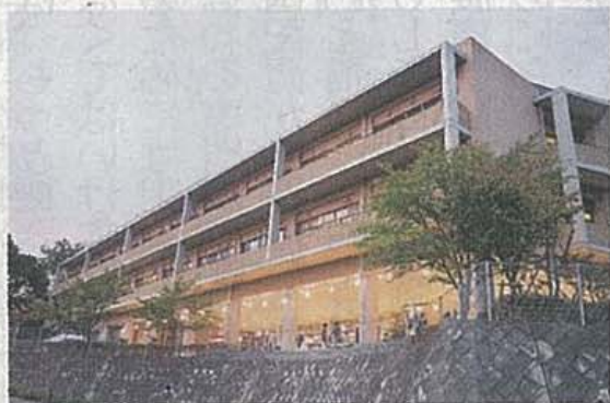
千里寮の外観
